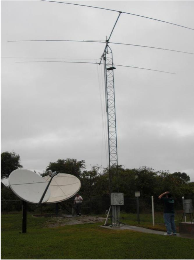
**20M Yagi rotatable beam**
